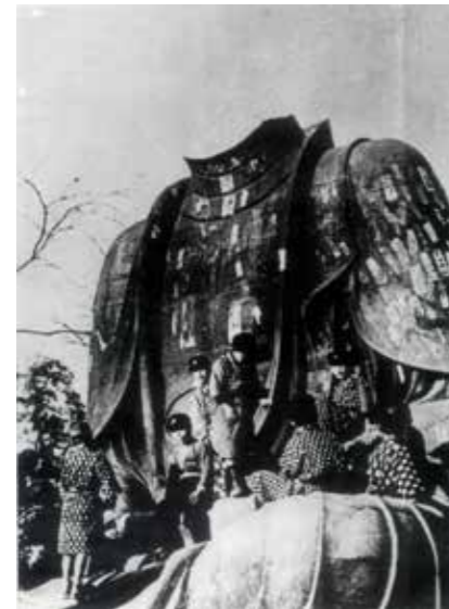
頭部が落下した上野大仏
